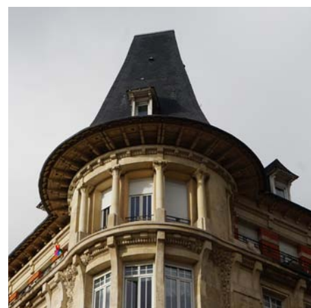
33 rue de Talleyrand, Reims.
