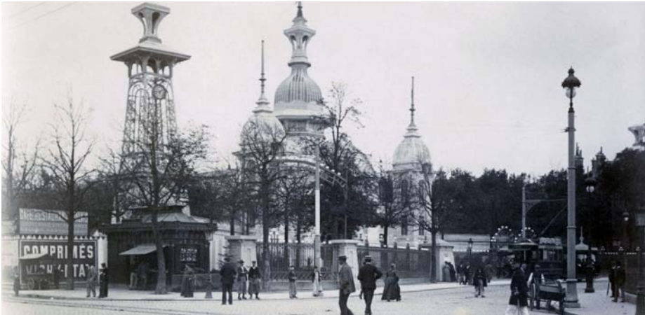
Entrée principale vue depuis la Gare de Reims. Photo amateur. Coll. L.A.
